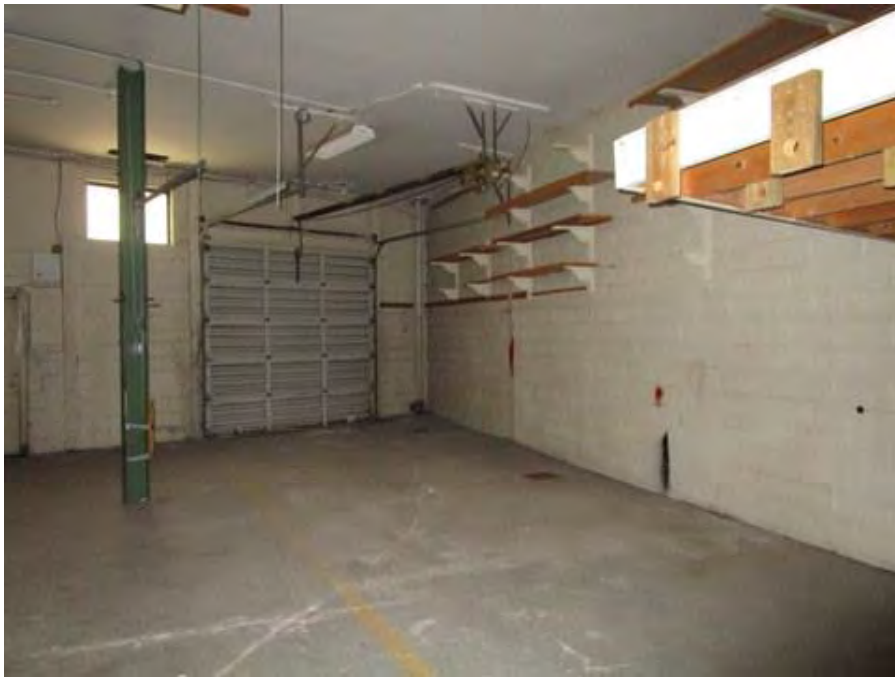
Vacant tenant space
