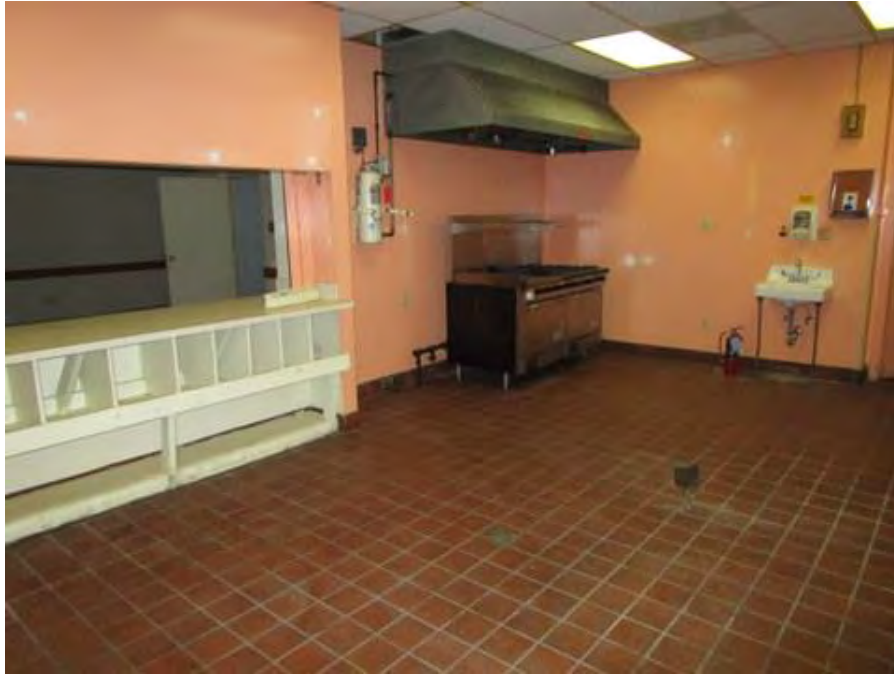
Vacant tenant space
