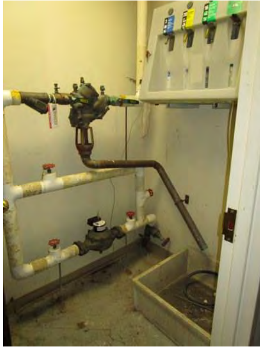
Janitor's closet in vacant tenant space
