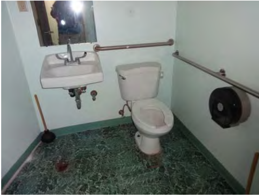
Typical tenant restroom
